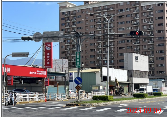
巡查日期地點：112.09.09/ Luzhou District Y22車站 照片說明：牌面設置狀況
