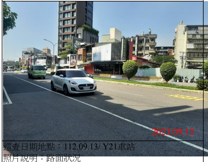
巡查日期地點：112.09.13/ Y21車站 照片說明：路面狀況
