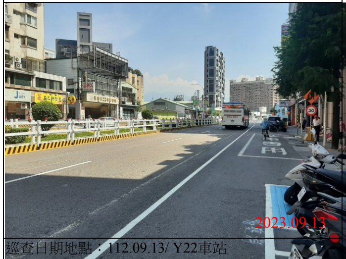
巡查日期地點：112.09.13/ Y22車站 照片說明：路面狀況
