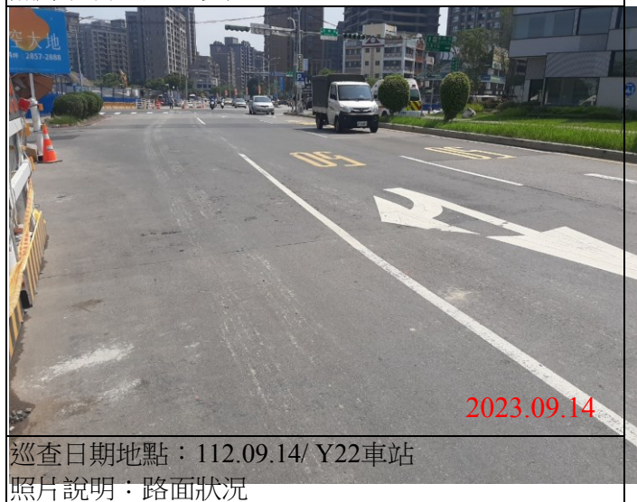
巡查日期地點：112.09.14/ Y22車站 照片說明：路面狀況
