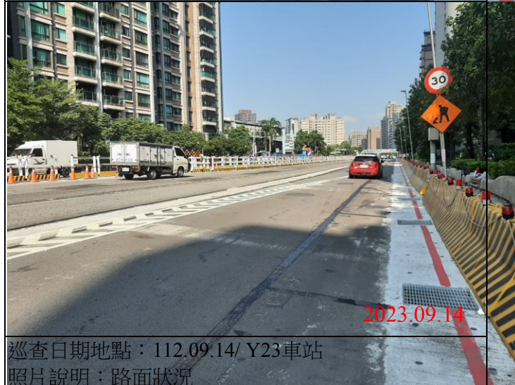
巡查日期地點：112.09.14/ Y23車站 照片說明：路面狀況
