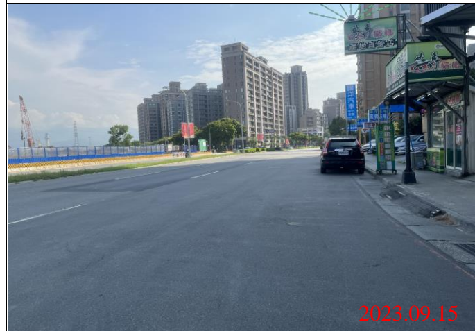
巡查日期地點：112.09.15/ Y22車站 照片說明：路面狀況
