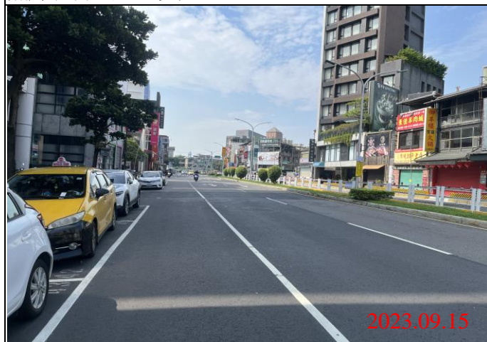
巡查日期地點：112.09.15/ Y21車站 照片說明：路面狀況
