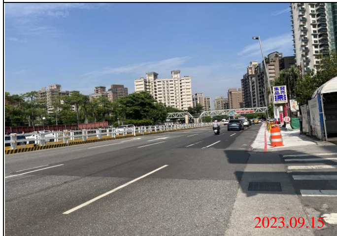
巡查日期地點：112.09.15/ Y23車站 照片說明：路面狀況
