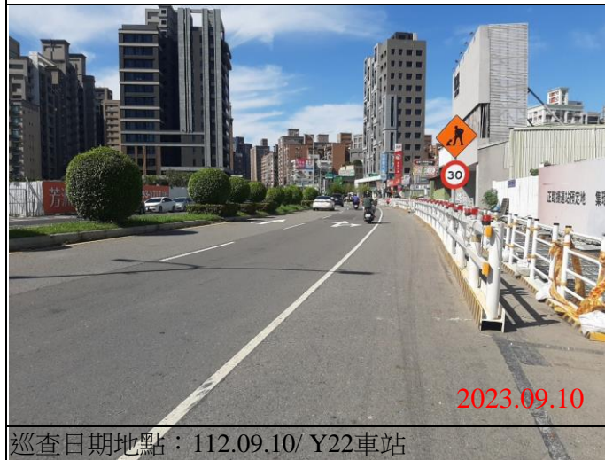
巡查日期地點：112.09.10/ Y22車站 照片說明：路面狀況
