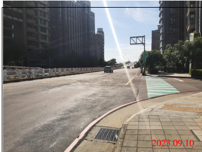
巡查日期地點：112.09.10/ Y23車站 照片說明：路面狀況
