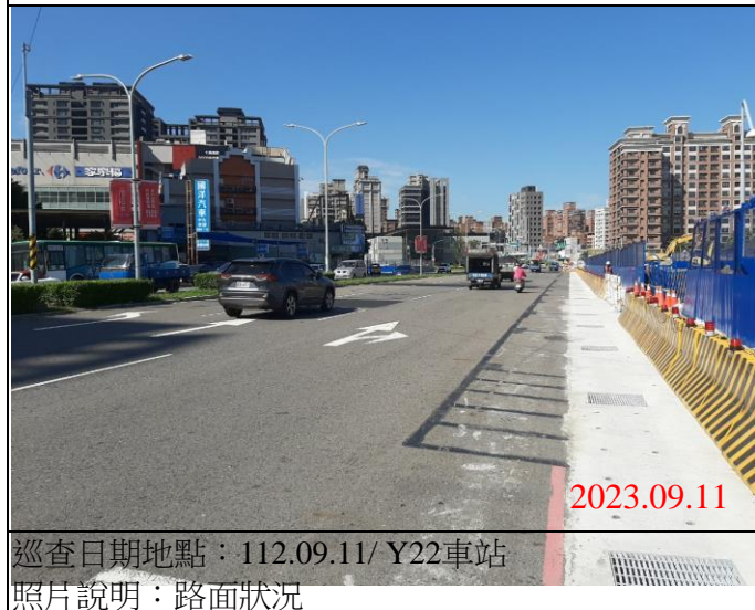
巡查日期地點：112.09.11/ Y22車站 照片說明：路面狀況
