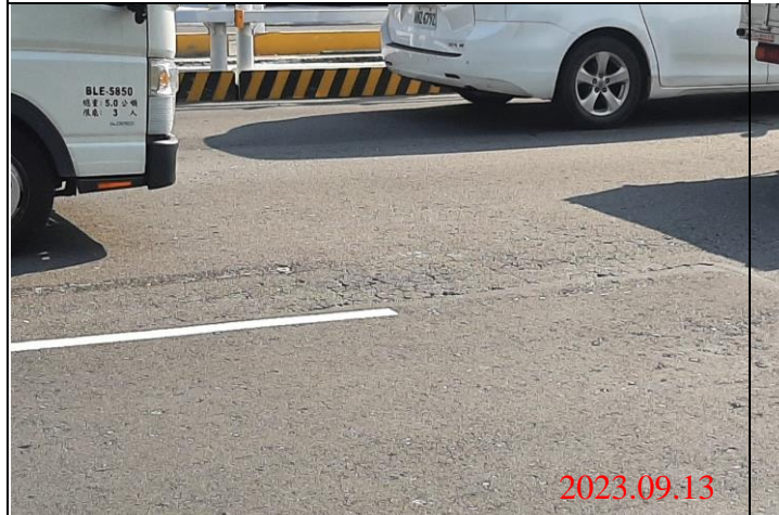
巡查日期地點：112.09.13/ Y23車站 照片說明：路面龜裂狀況
