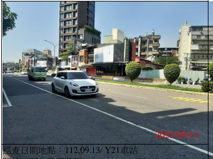
巡查日期地點：112.09.13/ Y21車站 照片說明：路面狀況
