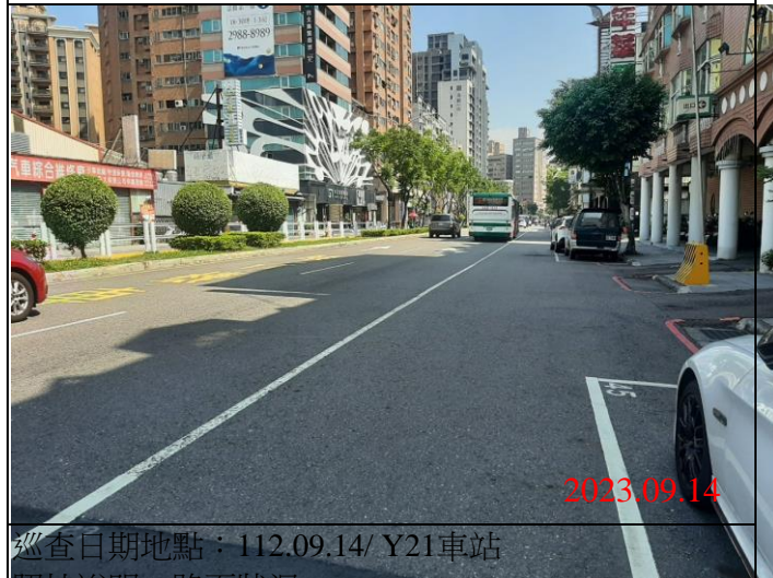
巡查日期地點：112.09.14/ Y21車站 照片說明：路面狀況
