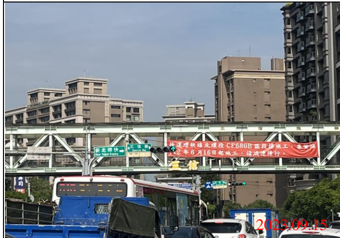
巡查日期地點：112.09.15/ Y23車站 照片說明：牌面設置狀況
