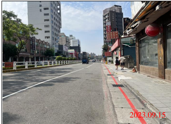
巡查日期地點：112.09.15/ Y21車站 照片說明：路面狀況
