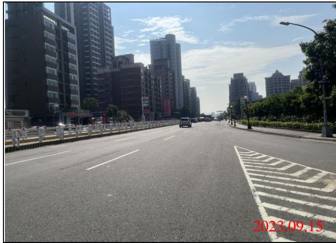
巡查日期地點：112.09.15/ Y23車站 照片說明：路面狀況
