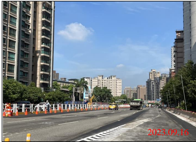
巡查日期地點：112.09.16/ Y23車站 照片說明：路面狀況
