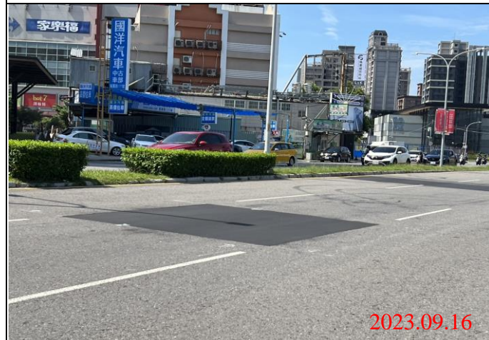
巡查日期地點：112.09.16/ Y22車站 照片說明：路面狀況
