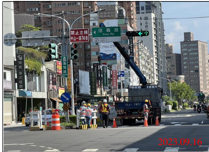
巡查日期地點：112.09.16/ Y21車站 照片說明：牌面設置狀況
