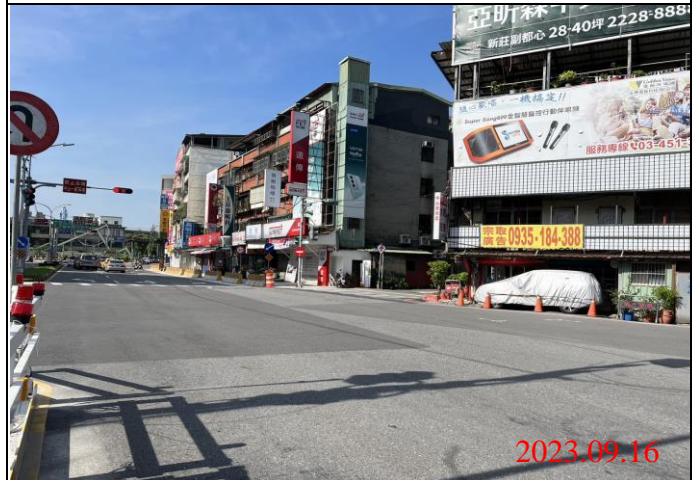
巡查日期地點：112.09.16/ Y21車站 照片說明：路面狀況
