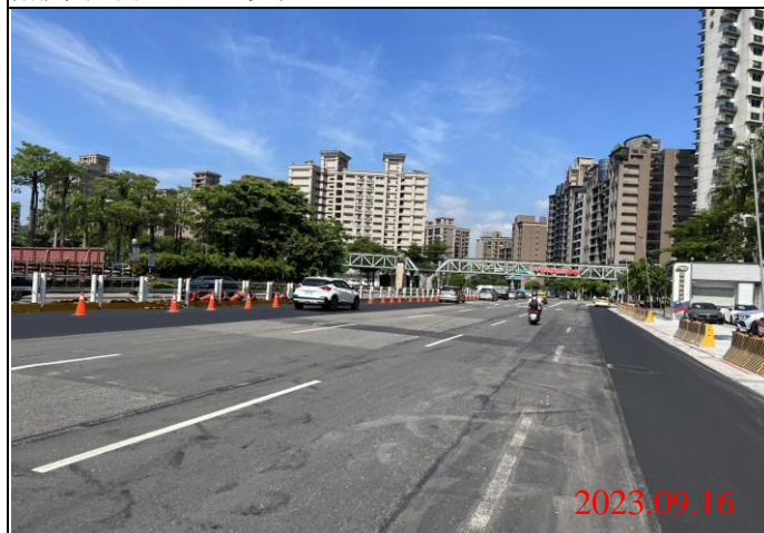
巡查日期地點：112.09.16/ Y23車站 照片說明：路面狀況
