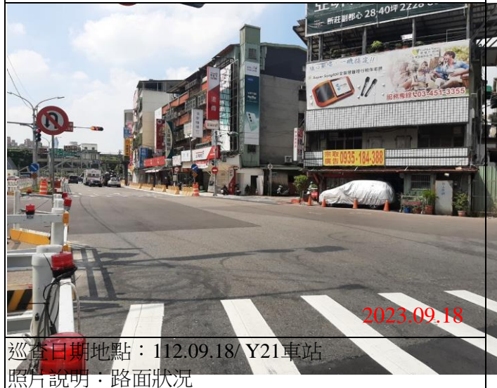
巡查日期地點：112.09.18/ Y21車站 照片說明：路面狀況
