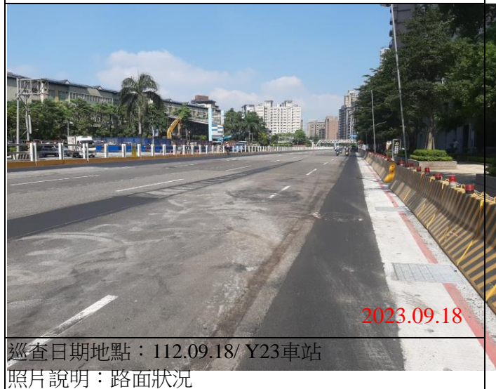
巡查日期地點：112.09.18/ Y23車站 照片說明：路面狀況
