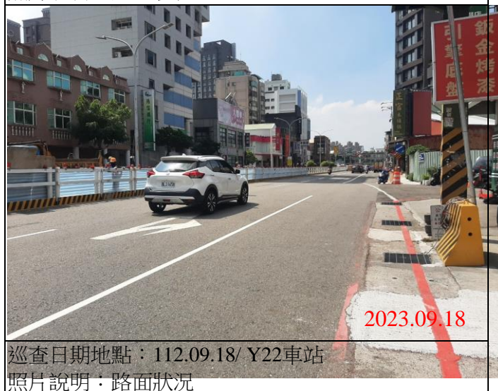
巡查日期地點：112.09.18/ Y22車站 照片說明：路面狀況
