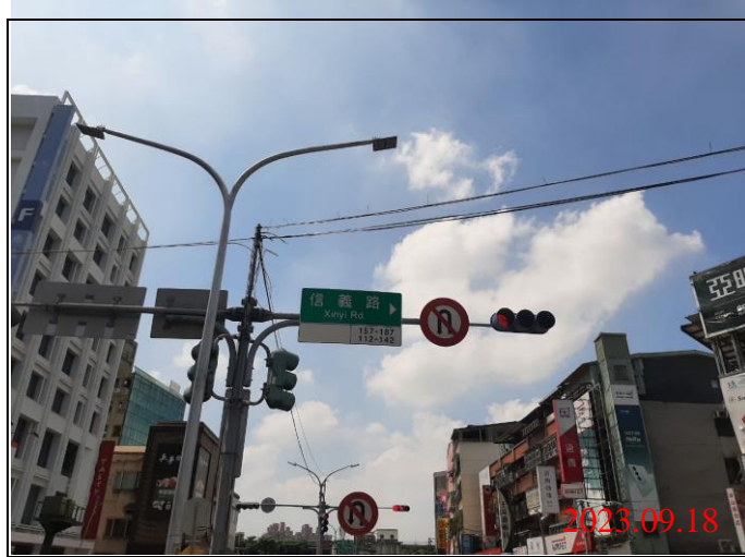
巡查日期地點：112.09.18/ Y21車站 照片說明：牌面設置狀況
