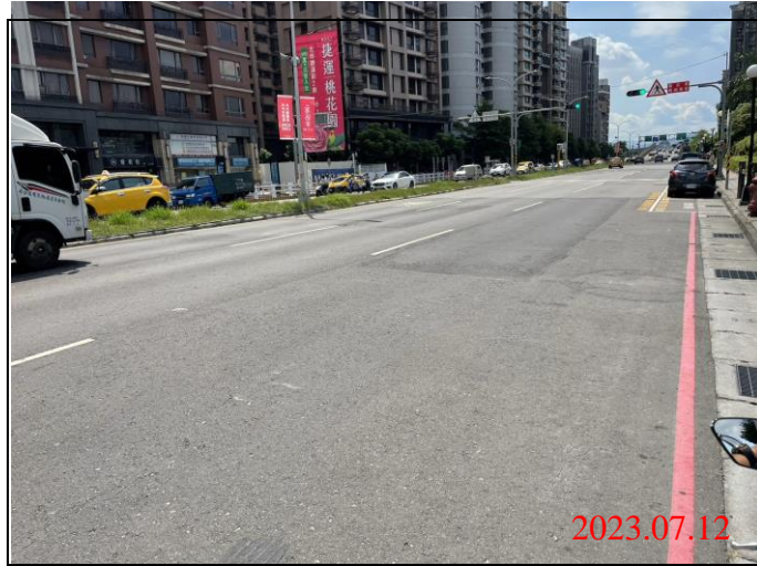
巡查日期地點：112.07.12/ Y23車站 照片說明：路面狀況
