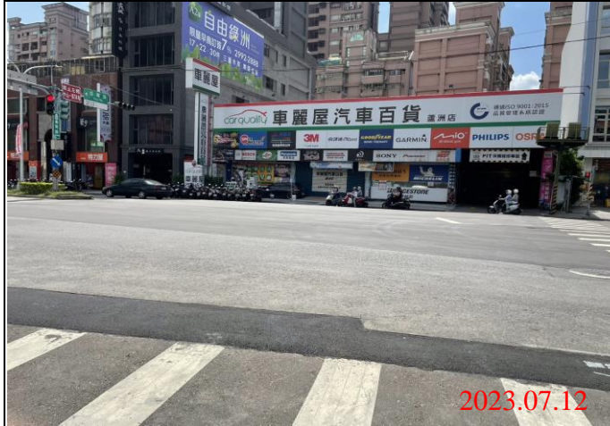
巡查日期地點：112.07.12/ Y21車站 照片說明：路面狀況
