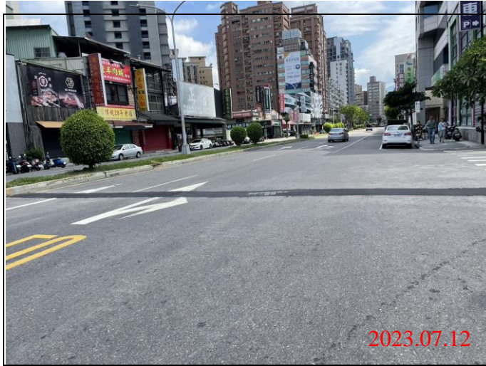
巡查日期地點：112.07.12/ Y21車站 照片說明：路面狀況
