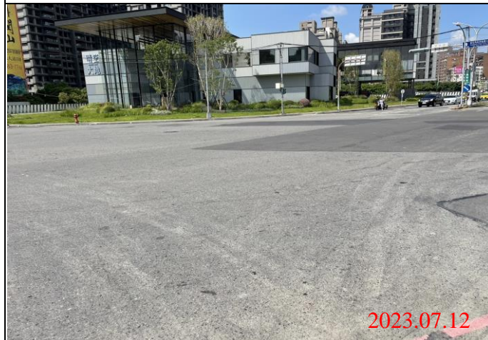
巡查日期地點：112.07.12/ Y22車站 照片說明：路面狀況
