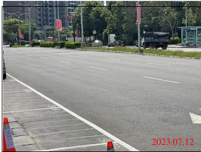
巡查日期地點：112.07.12/ Y22車站 照片說明：路面狀況
