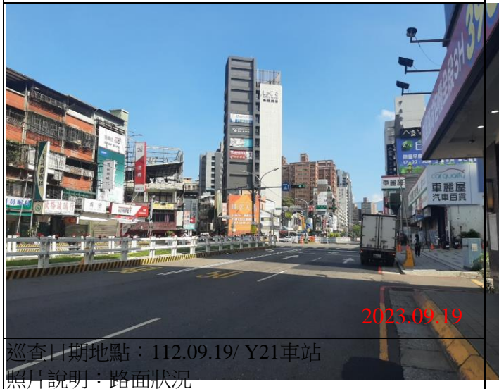
巡查日期地點：112.09.19/ Y21車站 照片說明：路面狀況
