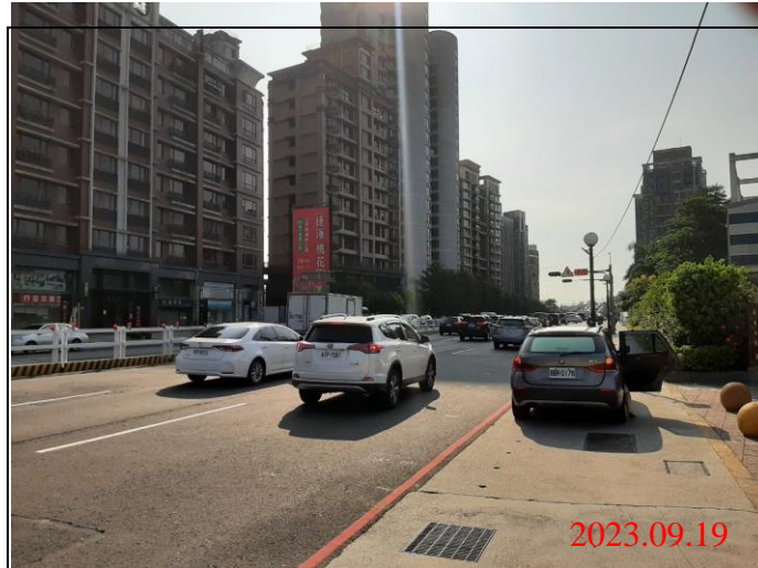
巡查日期地點：112.09.19/ Y23車站 照片說明：路面狀況
