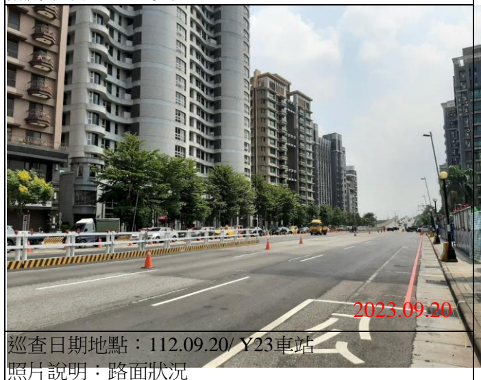
巡查日期地點：112.09.20/ Y23車站 照片說明：路面狀況
