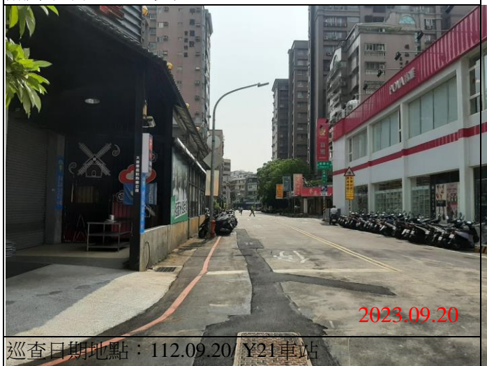
巡查日期地點：112.09.20/ Y21車站 照片說明：路面狀況
