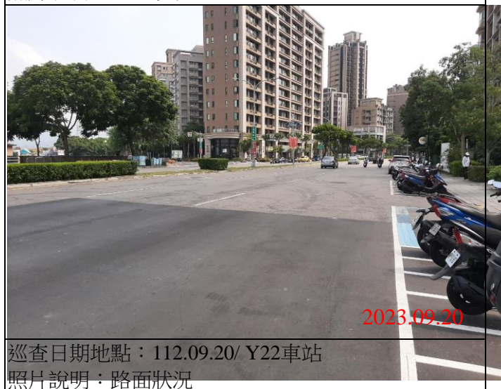
巡查日期地點：112.09.20/ Y22車站 照片說明：路面狀況
