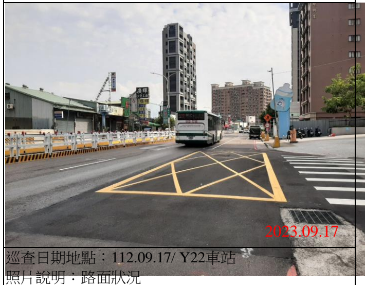
巡查日期地點：112.09.17/ Y22車站 照片說明：路面狀況
