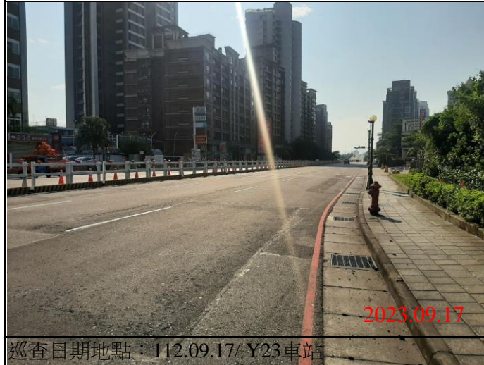
巡查日期地點：112.09.17/ Y23車站 照片說明：路面狀況
