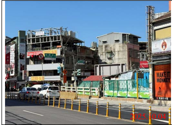
巡查日期地點：114.10.04/Y21車站 照片說明：牌面設置狀況
