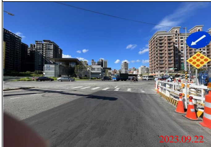
巡查日期地點：112.09.22/ Y22車站 照片說明：路面狀況
