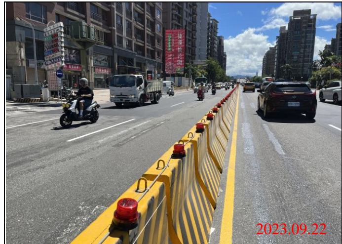
巡查日期地點：112.09.22/ Y23車站 照片說明：路面狀況
