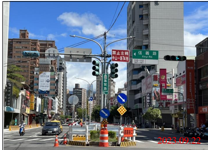
巡查日期地點：112.09.22/ Y21車站 照片說明：牌面設置狀況
