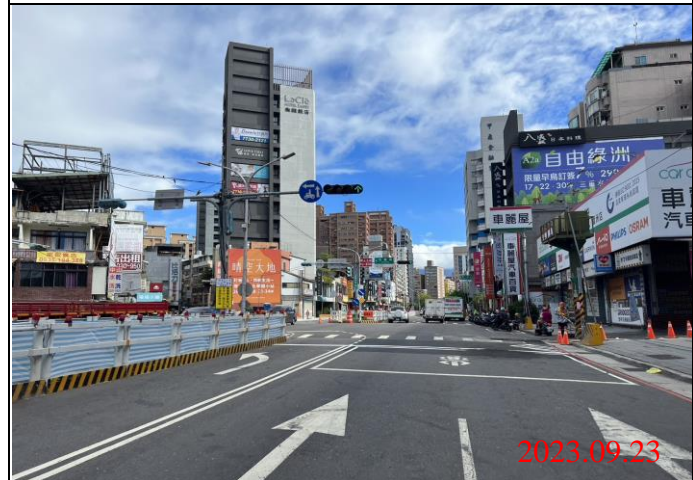
巡查日期地點：112.09.23/ Y21車站 照片說明：路面狀況
