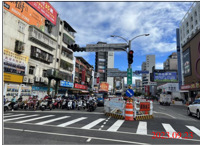
巡查日期地點：112.09.23/ Y21車站 照片說明：牌面設置狀況
