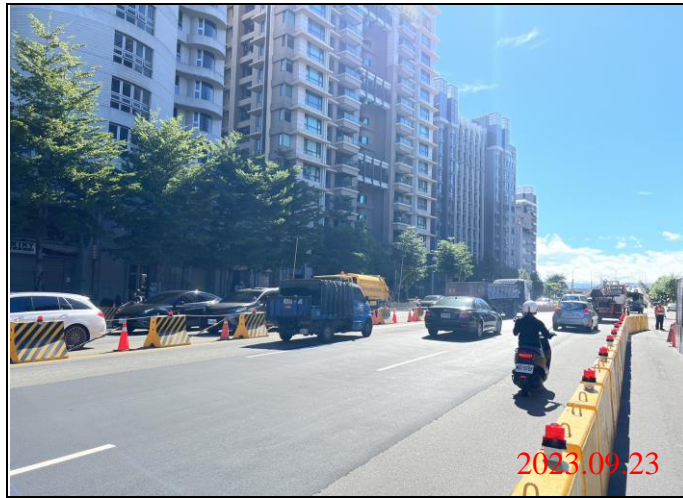
巡查日期地點：112.09.23/ Y23車站 照片說明：路面狀況
