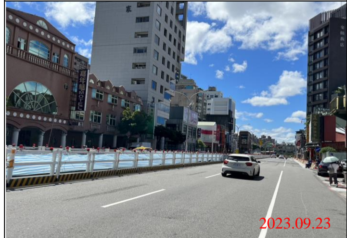
巡查日期地點：112.09.23/ Y21車站 照片說明：路面狀況
