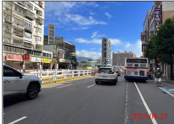
巡查日期地點：112.09.23/ Y22車站 照片說明：路面狀況
