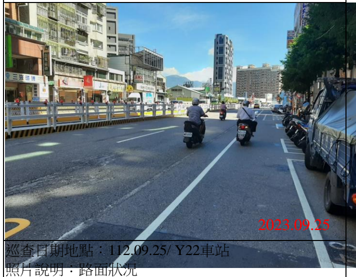
巡查日期地點：112.09.25/ Y22車站 照片說明：路面狀況
