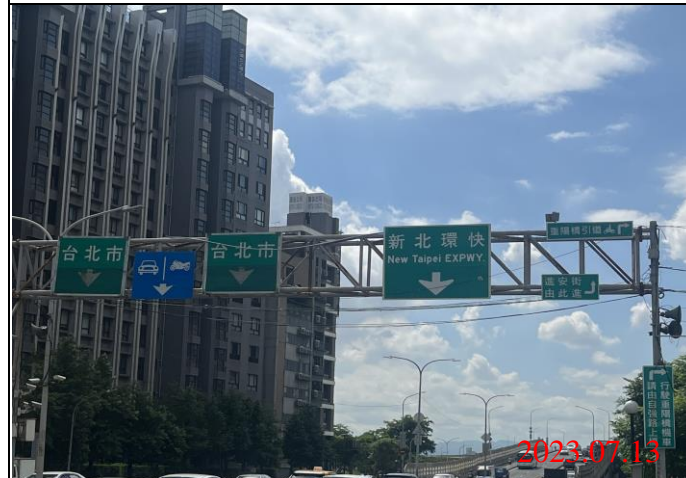
巡查日期地點：112.07.13/ Y23車站 照片說明：牌面設置狀況
