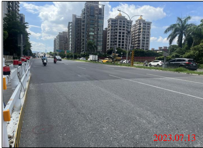
巡查日期地點：112.07.13/ Y23車站 照片說明：路面狀況
