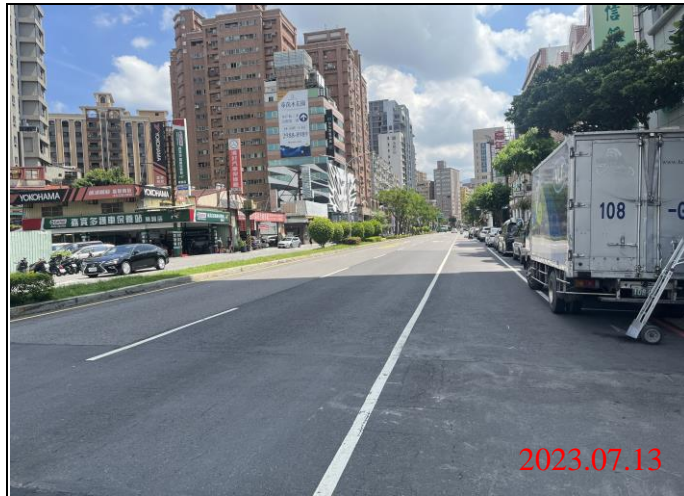
巡查日期地點：112.07.13/ Y21車站 照片說明：路面狀況
