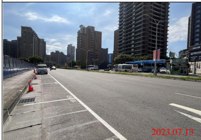
巡查日期地點：112.07.13/ Y22車站 照片說明：路面狀況
