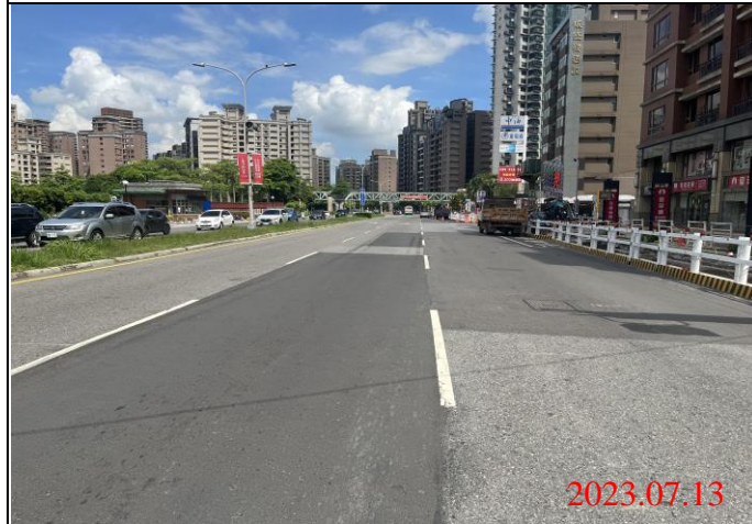
巡查日期地點：112.07.13/ Y23車站 照片說明：路面狀況
