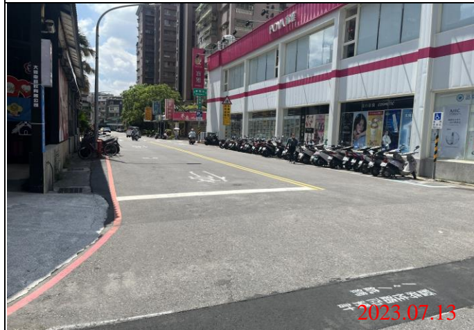
巡查日期地點：112.07.13/ Y21車站 照片說明：路面狀況
