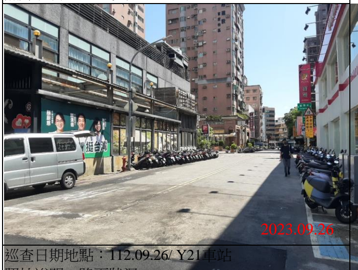
巡查日期地點：112.09.26/ Y21車站 照片說明：路面狀況
