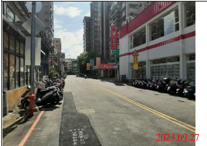
巡查日期地點：112.09.27/ Y21車站 照片說明：路面狀況
