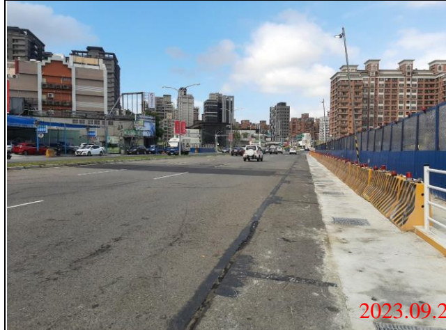
巡查日期地點：112.09.27/ Y22車站 照片說明：路面狀況
