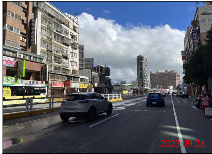
巡查日期地點：112.09.28/ Y22車站 照片說明：路面狀況
