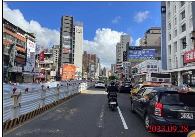
巡查日期地點：112.09.28/ Y21車站 照片說明：路面狀況
