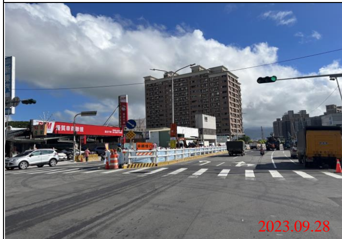
巡查日期地點：112.09.28/ Y22車站 照片說明：路面狀況
