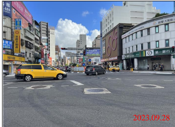
巡查日期地點：112.09.28/ Y21車站 照片說明：路面狀況
