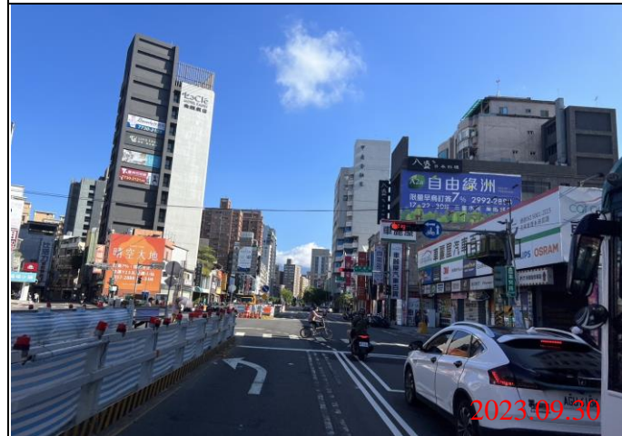
巡查日期地點：112.09.30/ Y21車站 照片說明：路面狀況
