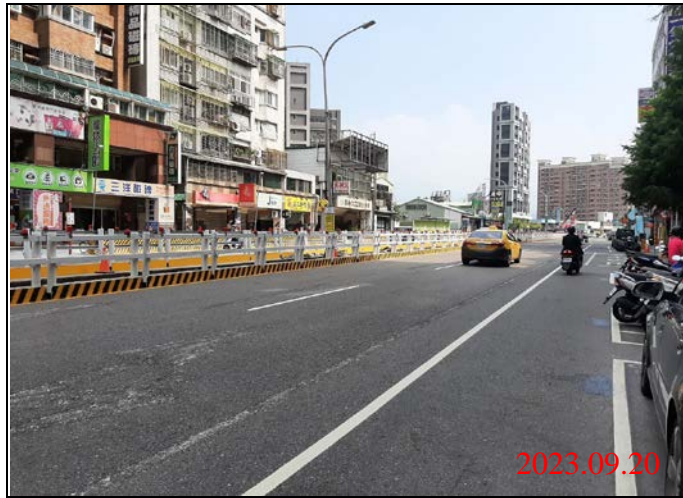
巡查日期地點：112.09.20/ Y22車站 照片說明：路面狀況
