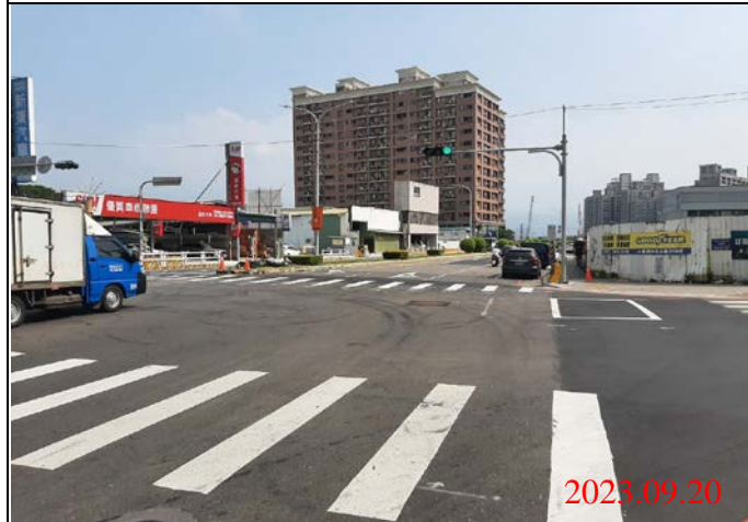
巡查日期地點：112.09.20/ Y22車站 照片說明：路面狀況
