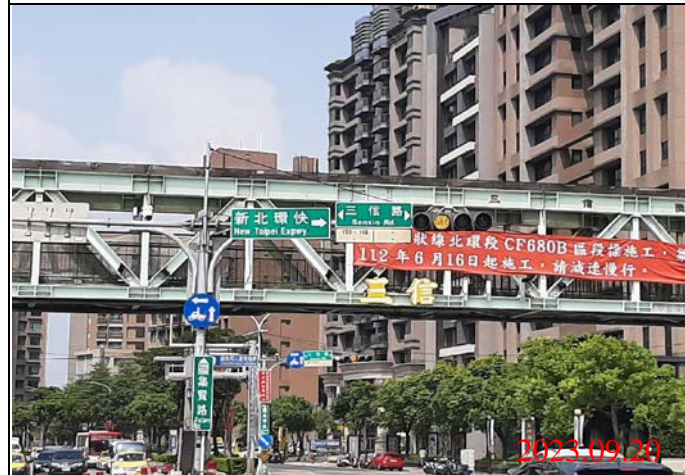
巡查日期地點：112.09.20/ Y23車站 照片說明：牌面設置狀況
