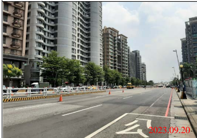
巡查日期地點：112.09.20/ Y23車站 照片說明：路面狀況
