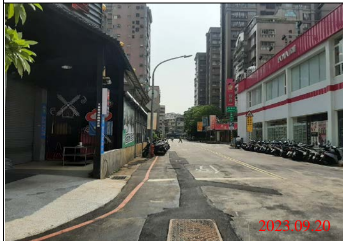
巡查日期地點：112.09.20/ Y21車站 照片說明：路面狀況
