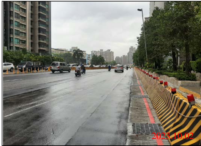
巡查日期地點：112.10.02 Y23車站 照片說明：路面狀況
