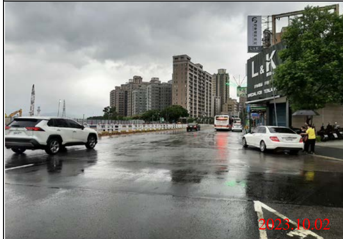
巡查日期地點：112.10.02/ Y22車站 照片說明：路面狀況
