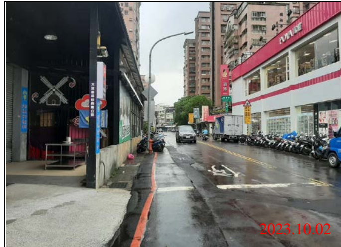
巡查日期地點：112.10.02/ Y21車站 照片說明：路面狀況
