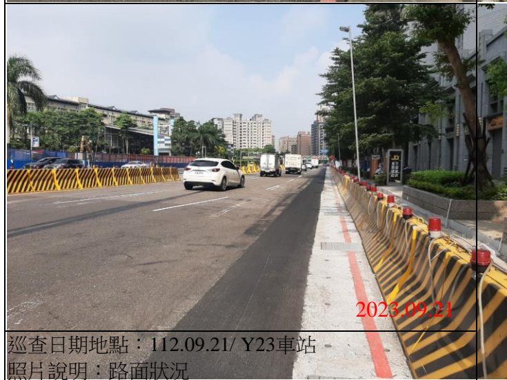
巡查日期地點：112.09.21/ Y23車站 照片說明：路面狀況
