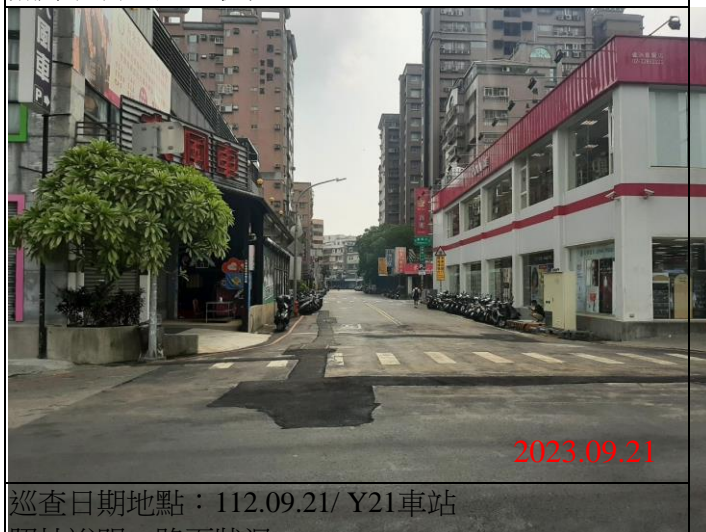
巡查日期地點：112.09.21/ Y21車站 照片說明：路面狀況
