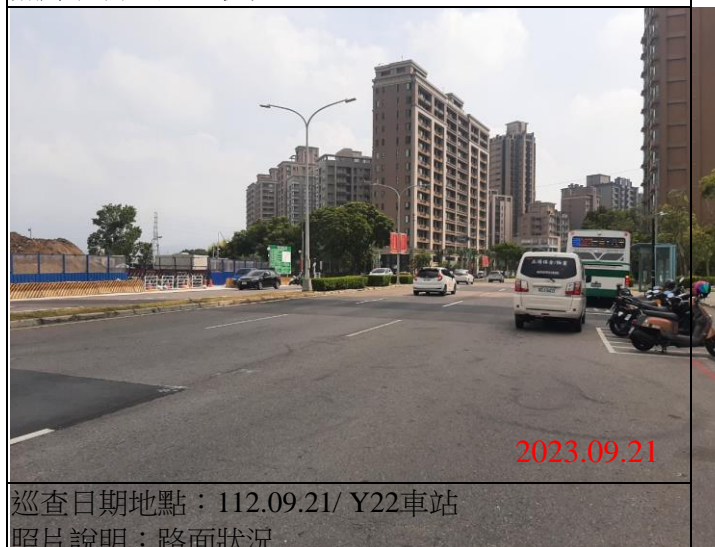
巡查日期地點：112.09.21/ Y22車站 照片說明：路面狀況
