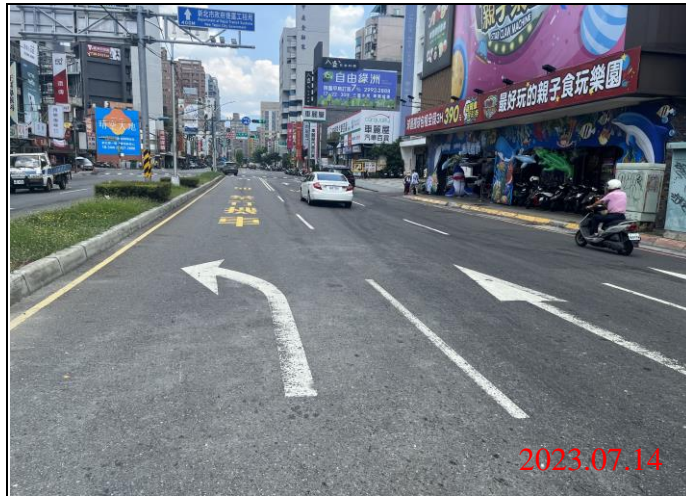
巡查日期地點：112.07.14/ Y21車站 照片說明：路面狀況
