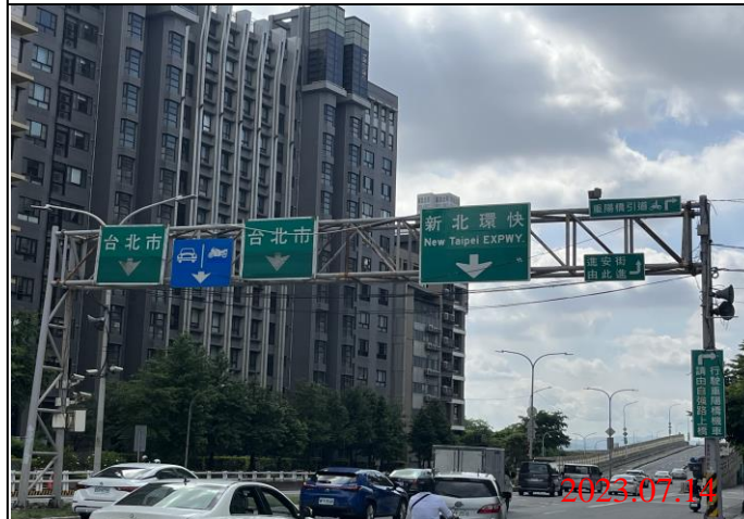
巡查日期地點：112.07.14/ Y23車站 照片說明：牌面設置狀況
