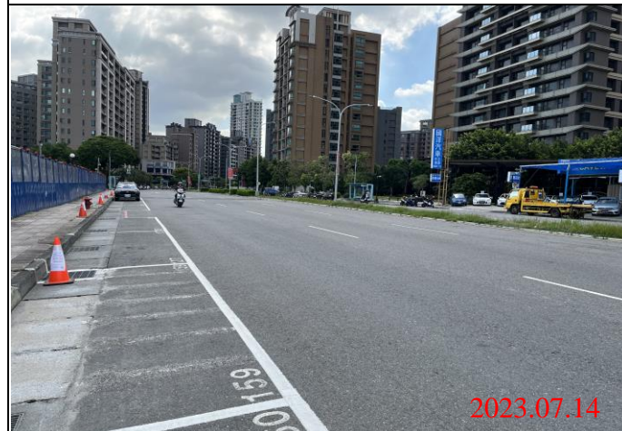
巡查日期地點：112.07.14/ Y22車站 照片說明：路面狀況
