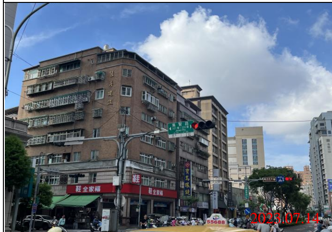
巡查日期地點：112.07.14/ Y22車站 照片說明：牌面設置狀況
