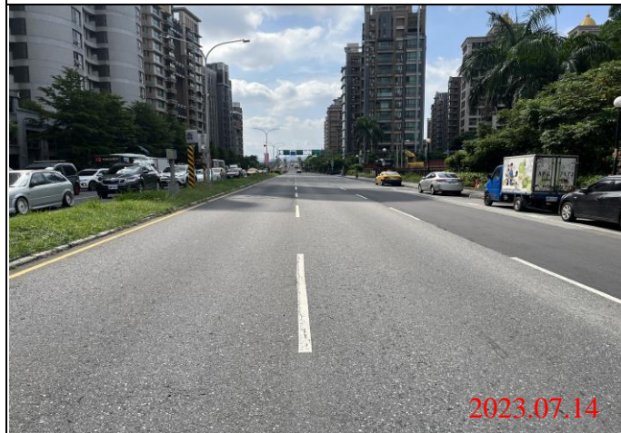
巡查日期地點：112.07.14/ Y23車站 照片說明：路面狀況
