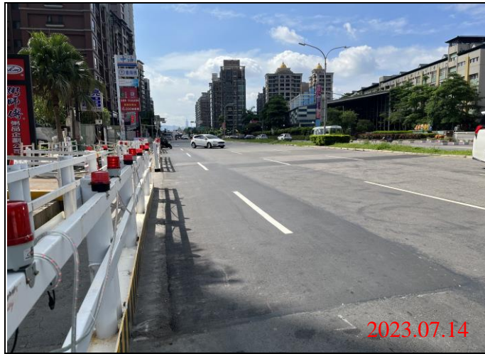
巡查日期地點：112.07.14/ Y23車站 照片說明：路面狀況
