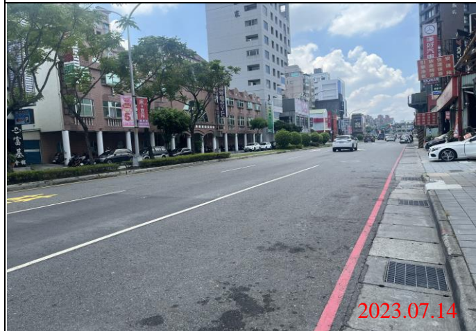
巡查日期地點：112.07.14/ Y21車站 照片說明：路面狀況
