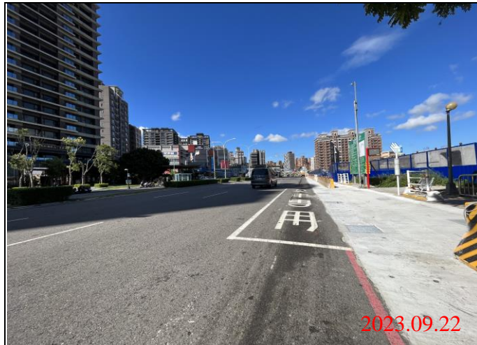
巡查日期地點：112.09.22/ Y22車站 照片說明：路面狀況
