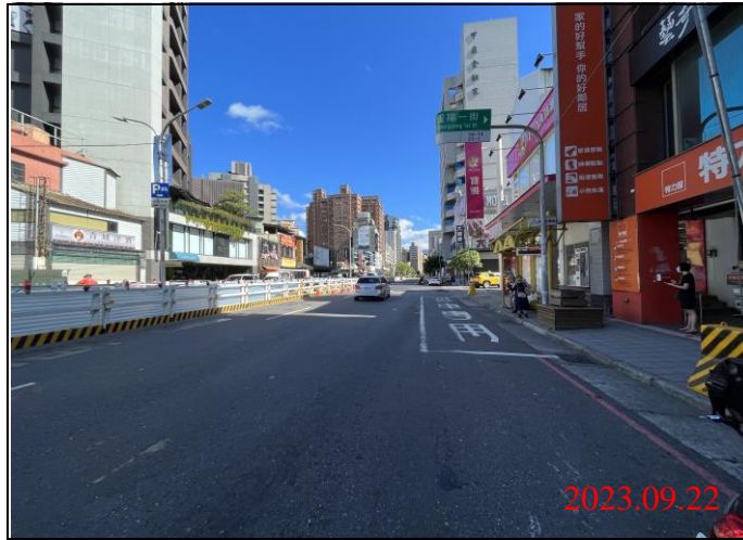
巡查日期地點：112.09.22/ Y21車站 照片說明：路面狀況
