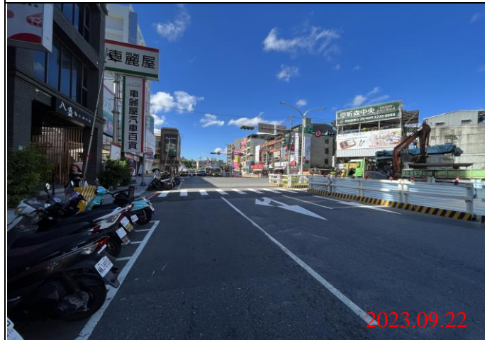
巡查日期地點：112.09.22/ Y21車站 照片說明：路面狀況
