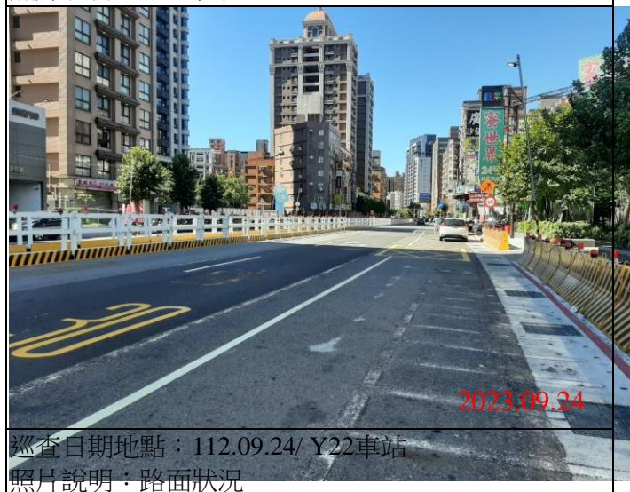
巡查日期地點：112.09.24/ Y22車站 照片說明：路面狀況
