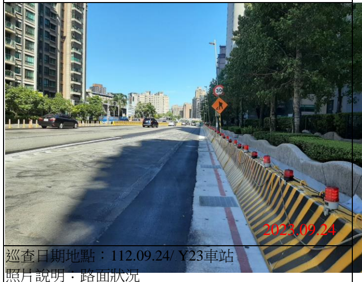
巡查日期地點：112.09.24/ Y23車站 照片說明：路面狀況
