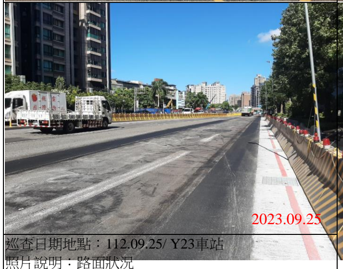
巡查日期地點：112.09.25/ Y23車站 照片說明：路面狀況
