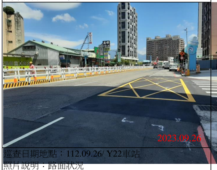
巡查日期地點：112.09.26/ Y22車站 照片說明：路面狀況
