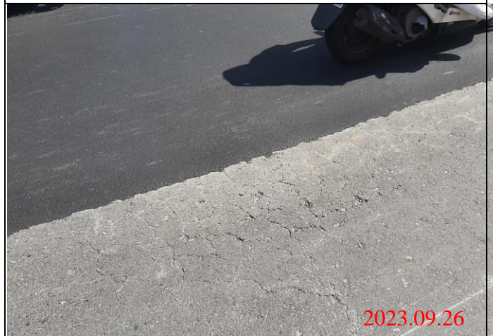
巡查日期地點：112.09.26/ Y23車站 照片說明：路面龜裂狀況
