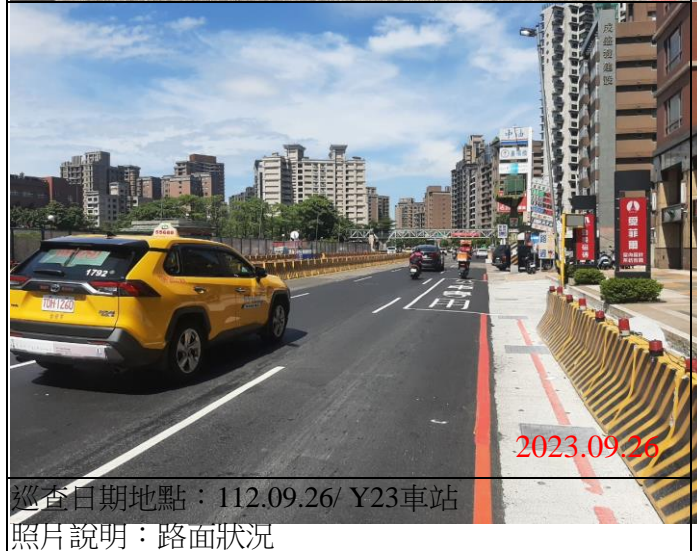
巡查日期地點：112.09.26/ Y23車站 照片說明：路面狀況
