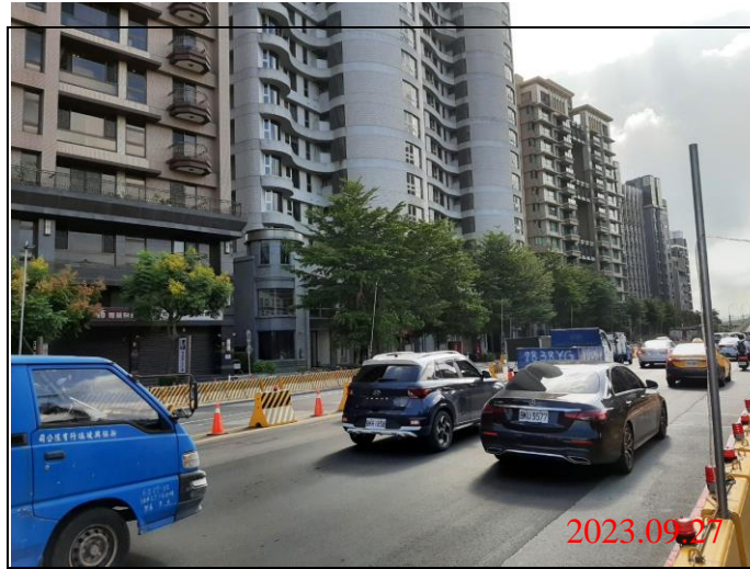
巡查日期地點：112.09.27/ Y23車站 照片說明：路面狀況
