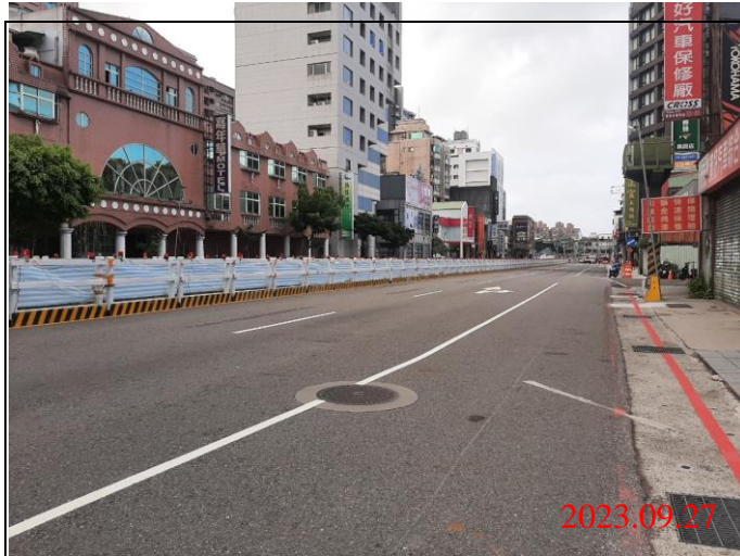
巡查日期地點：112.09.27/ Y21車站 照片說明：路面狀況
