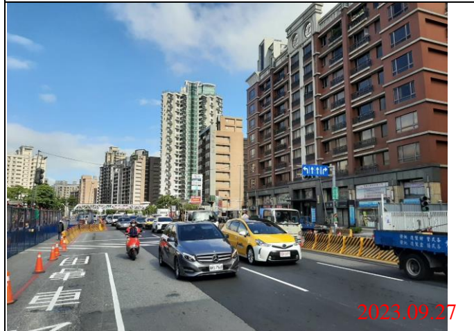
巡查日期地點：112.09.27/ Y23車站 照片說明：路面狀況
