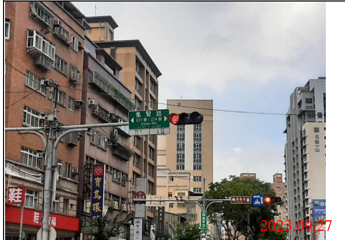
巡查日期地點：112.09.27/ Y22車站 照片說明：牌面設置狀況
