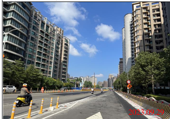
巡查日期地點：112.09.29 Y23車站 照片說明：路面狀況
