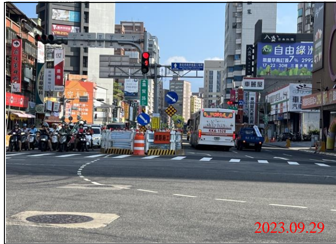
巡查日期地點：112.09.29 Y21車站 照片說明：牌面設置狀況
