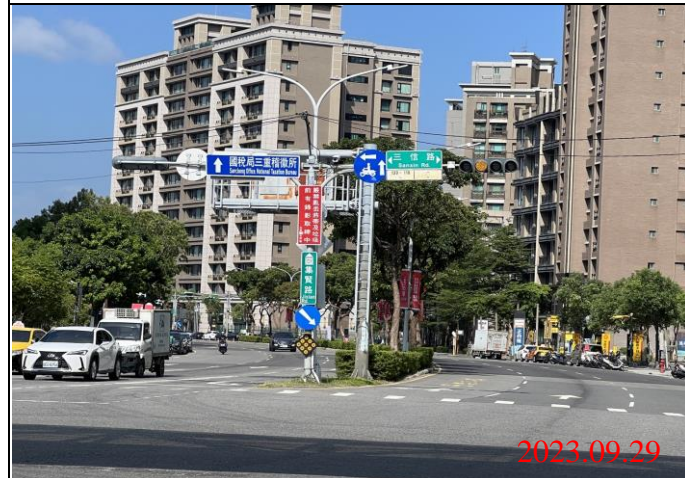
巡查日期地點：112.09.29 Y23車站 照片說明：牌面設置狀況
