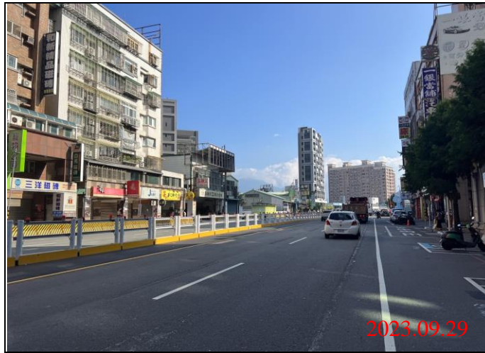
巡查日期地點：112.09.29/ Y22車站 照片說明：路面狀況
