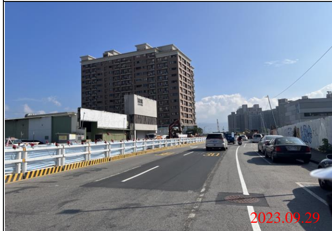
巡查日期地點：112.09.9 Y22車站 照片說明：路面狀況
