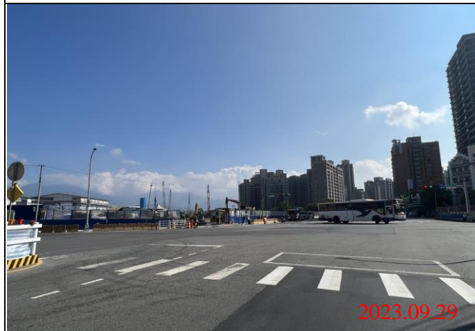
巡查日期地點：112.09.29 Y22車站 照片說明：路面狀況
