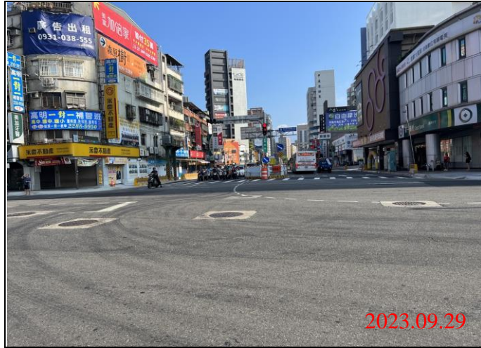
巡查日期地點：112.09.29/ Y21車站 照片說明：路面狀況
