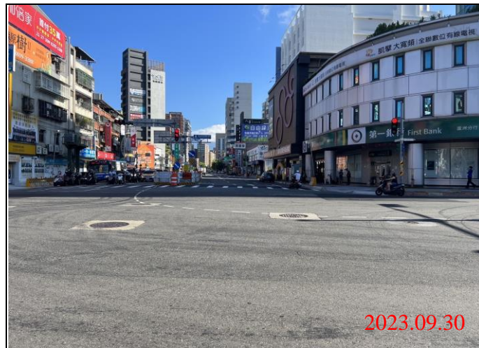
巡查日期地點：112.09.30/ Y21車站 照片說明：路面狀況
