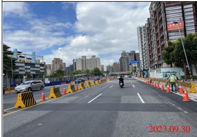
巡查日期地點：112.09.30 Y23車站 照片說明：路面狀況
