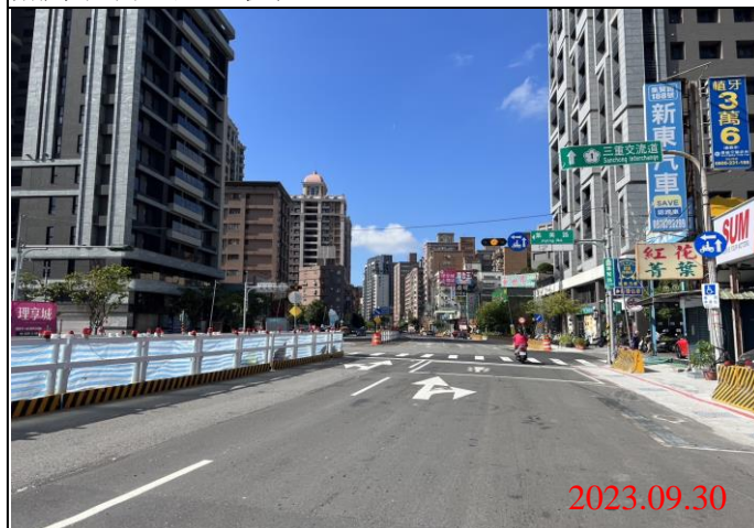
巡查日期地點：112.09.30 Y22車站 照片說明：路面狀況
