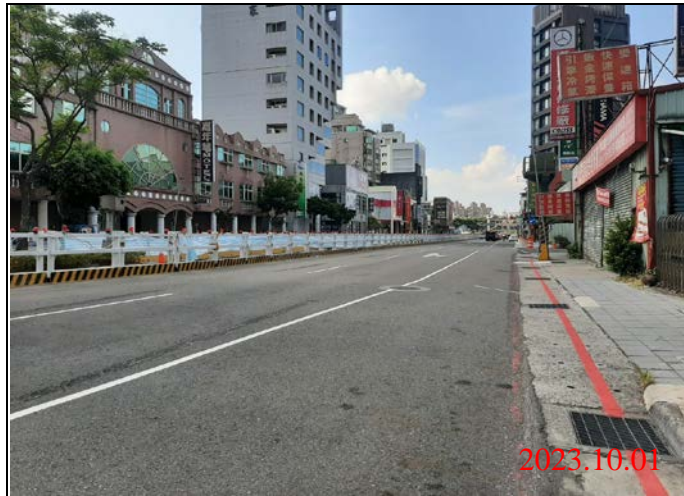
巡查日期地點：112.10.01/ Y21車站 照片說明：路面狀況
