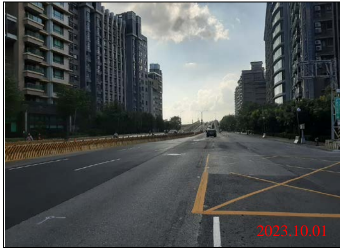
巡查日期地點：112.10.01/ Y23車站 照片說明：路面狀況
