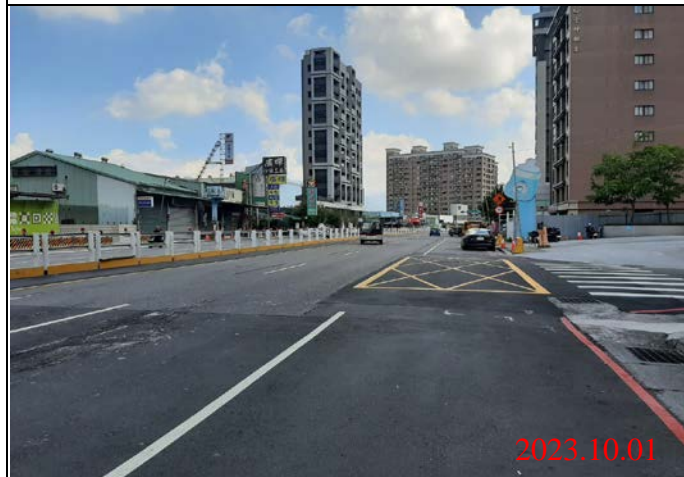
巡查日期地點：112.10.01/ Y22車站 照片說明：路面狀況
