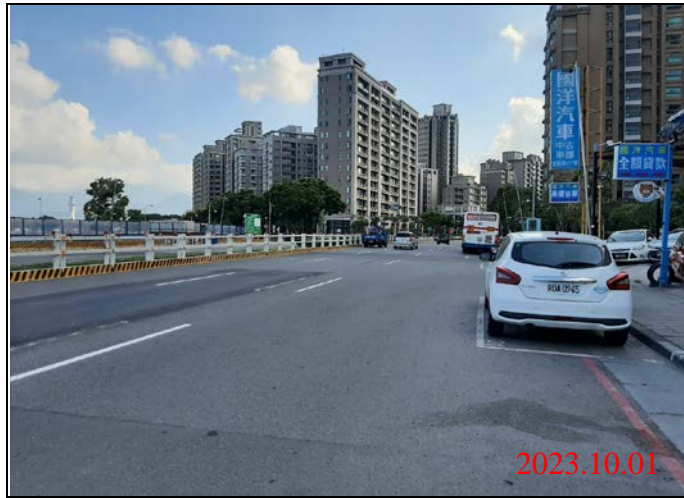
巡查日期地點：112.10.01/ Y22車站 照片說明：路面狀況
