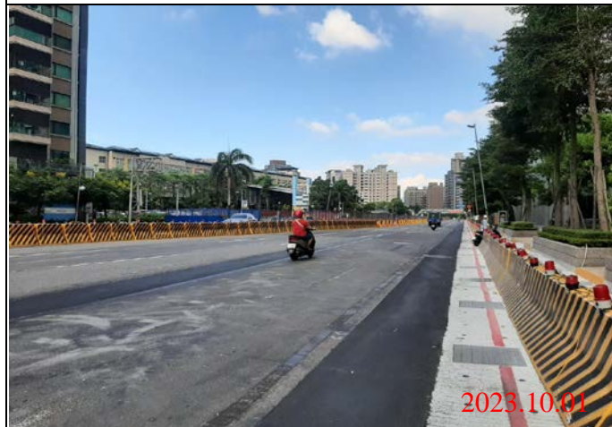
巡查日期地點：112.10.01/ Y23車站 照片說明：路面狀況
