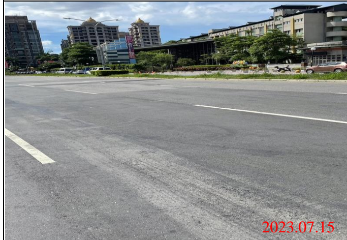
巡查日期地點：112.07.15/ Y23車站 照片說明：路面狀況
