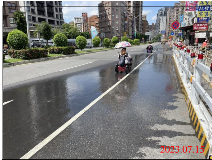
巡查日期地點：112.07.15/ Y22車站 照片說明：路面狀況
