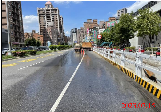
巡查日期地點：112.07.15/ Y22車站 照片說明：路面狀況
