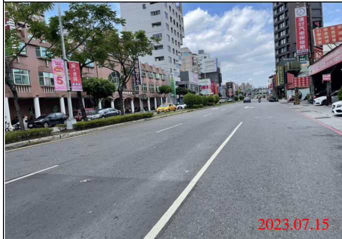
巡查日期地點：112.07.15/ Y21車站 照片說明：路面狀況
