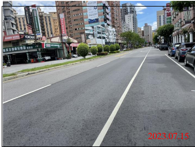
巡查日期地點：112.07.15/ Y21車站 照片說明：路面狀況
