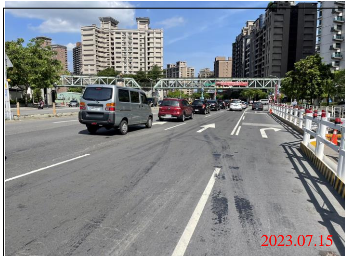
巡查日期地點：112.07.15/ Y23車站 照片說明：路面狀況
