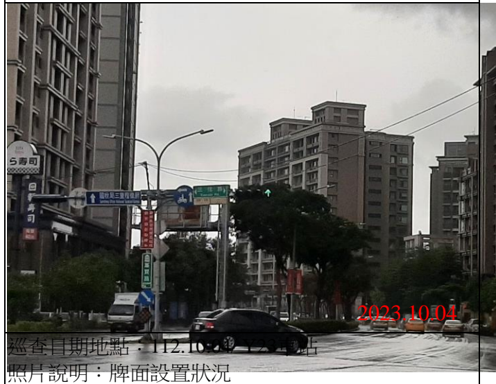
巡查日期地點：112.10.04/ Y22車站 照片說明：牌面設置狀況
