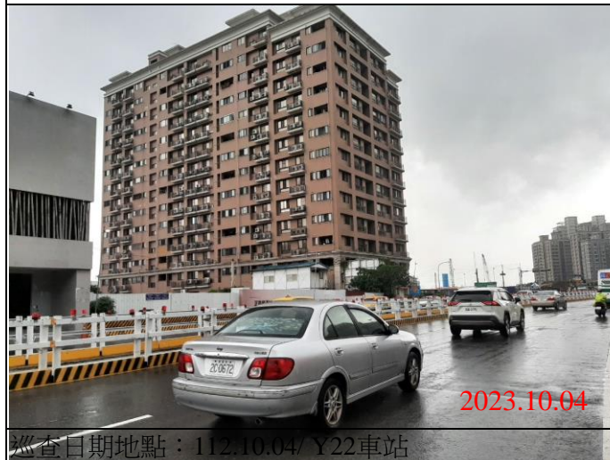
巡查日期地點：112.10.04/ Y22車站 照片說明：路面狀況
