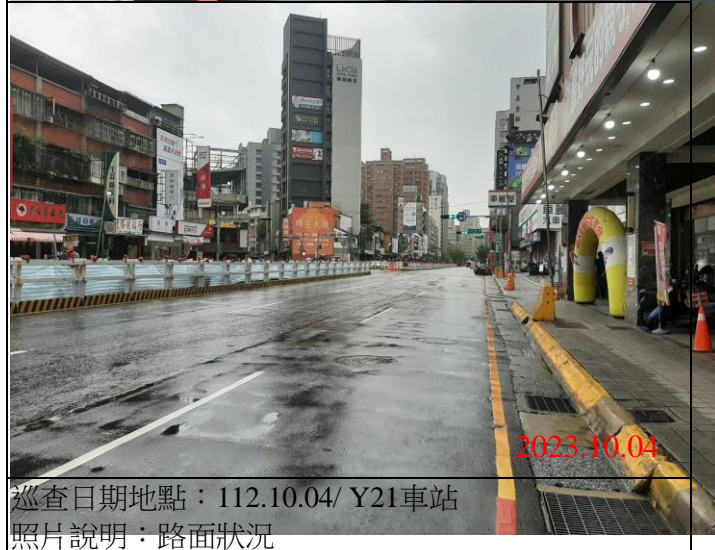
巡查日期地點：112.10.04/ Y21車站 照片說明：路面狀況
