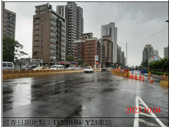
巡查日期地點：112.10.04/ Y23車站 照片說明：路面狀況
