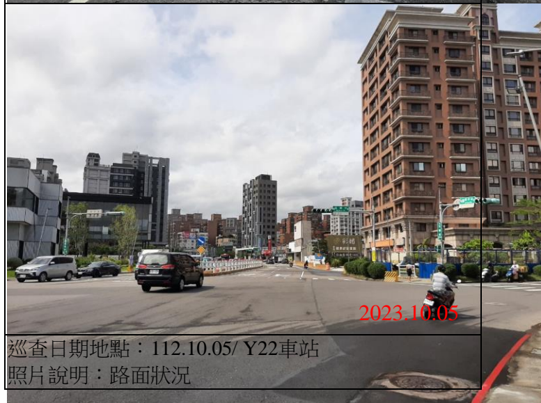
巡查日期地點：112.10.05/ Y22車站 照片說明：路面狀況
