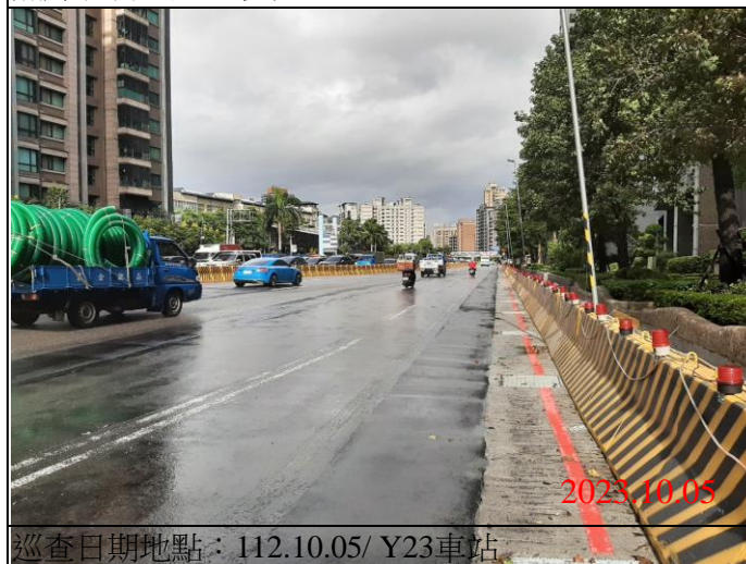
巡查日期地點：112.10.05/ Y23車站 照片說明：路面狀況
