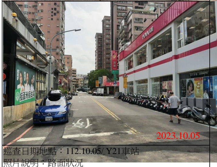
巡查日期地點：112.10.05/ Y21車站 照片說明：路面狀況
