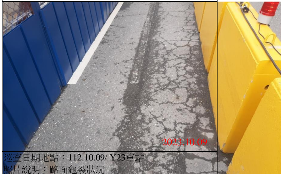
巡查日期地點：112.10.09/ Y23車站 照片說明：路面龜裂狀況
