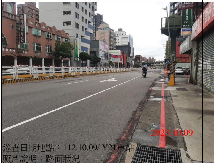
巡查日期地點：112.10.09/ Y21車站 照片說明：路面狀況
