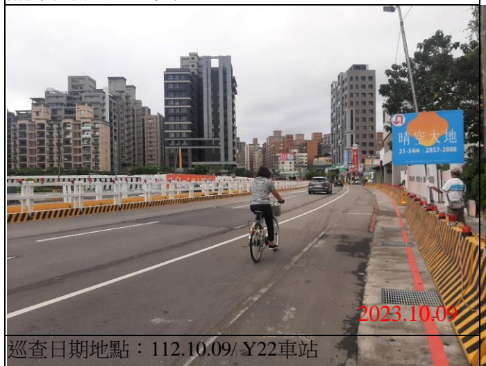
巡查日期地點：112.10.09/ Y22車站 照片說明：路面狀況
