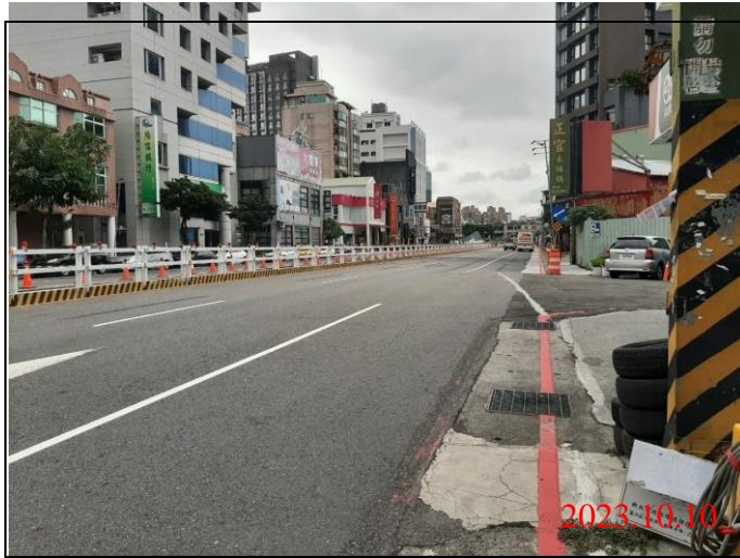
巡查日期地點：112.10.10/ Y21車站 照片說明：路面狀況
