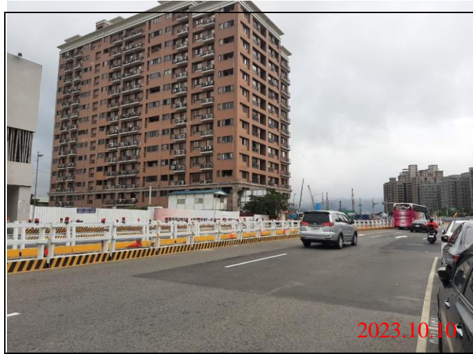
巡查日期地點：112.10.10/ Y22車站 照片說明：路面狀況
