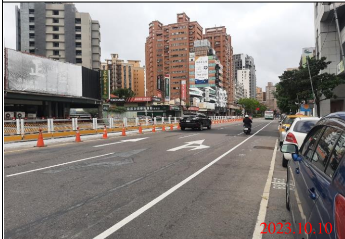
巡查日期地點：112.10.10/ Y21車站 照片說明：路面狀況
