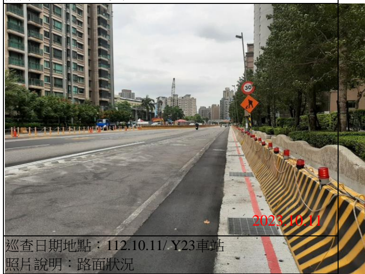
巡查日期地點：112.10.11/ Y23車站 照片說明：路面狀況
