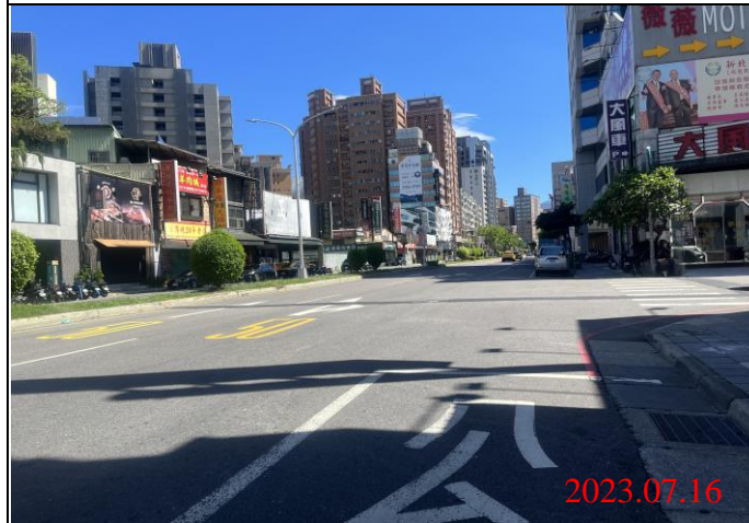
巡查日期地點：112.07.16/ Y21車站 照片說明：路面狀況
