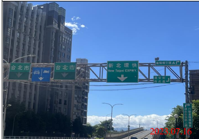
巡查日期地點：112.07.16/ Y23車站 照片說明：牌面設置狀況
