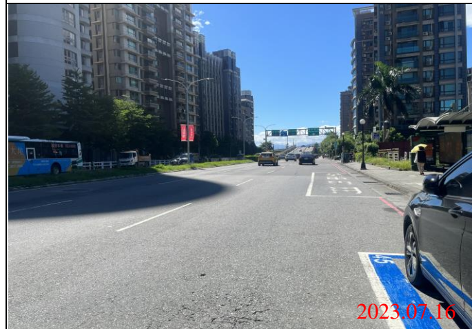
巡查日期地點：112.07.16/ Y23車站 照片說明：路面狀況
