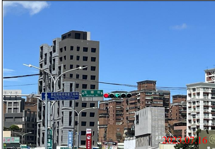
巡查日期地點：112.07.16/ Y22車站 照片說明：牌面設置狀況
