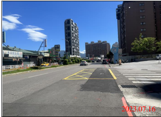
巡查日期地點：112.07.16/ Y22車站 照片說明：路面狀況
