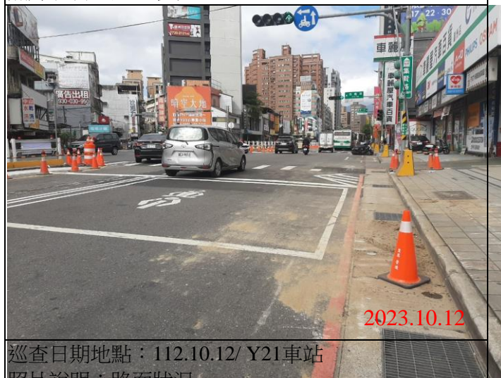
巡查日期地點：112.10.12/ Y21車站 照片說明：路面狀況
