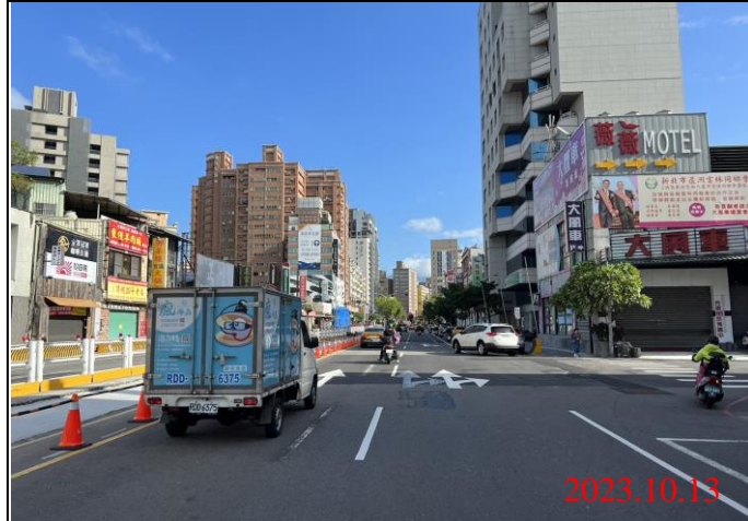
巡查日期地點：112.10.13/ Y21車站 照片說明：路面狀況
