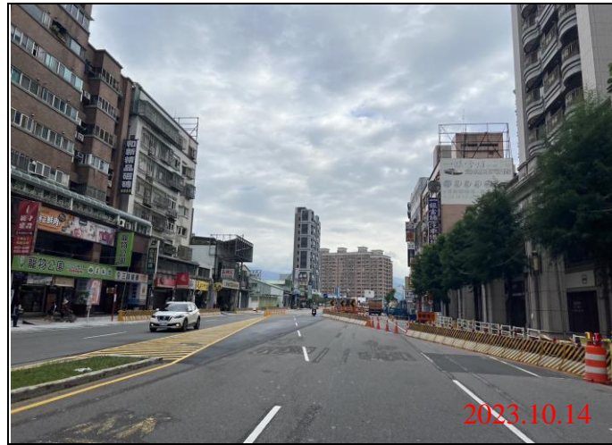
巡查日期地點：112.10.14/ Y22車站 照片說明：路面狀況
