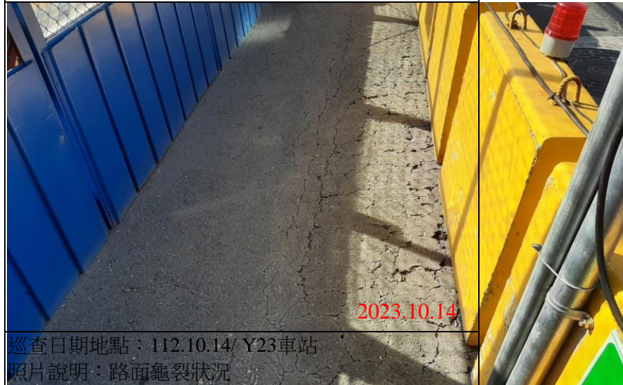
巡查日期地點：112.10.14/ Y23車站 照片說明：路面龜裂狀況
