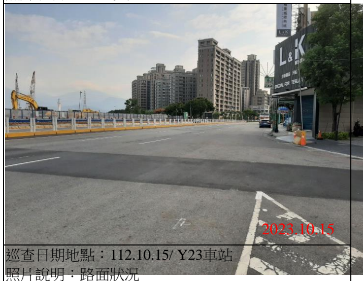
巡查日期地點：112.10.15/ Y23車站 照片說明：路面狀況
