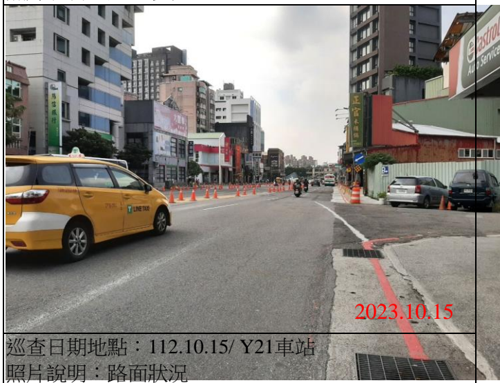
巡查日期地點：112.10.15/ Y21車站 照片說明：路面狀況
