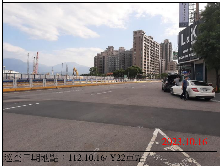
巡查日期地點：112.10.16/ Y22車站 - 照片說明：路面狀況
