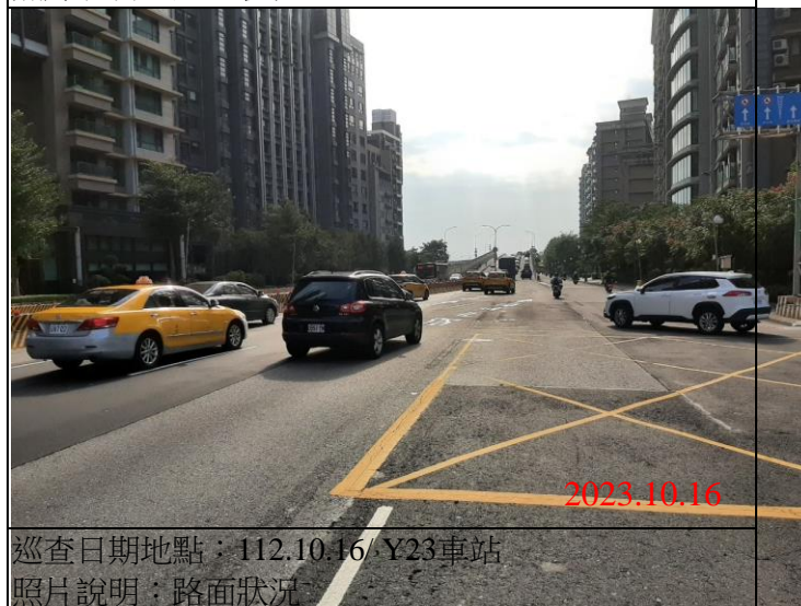
巡查日期地點：112.10.16/ Y23車站 照片說明：路面狀況
