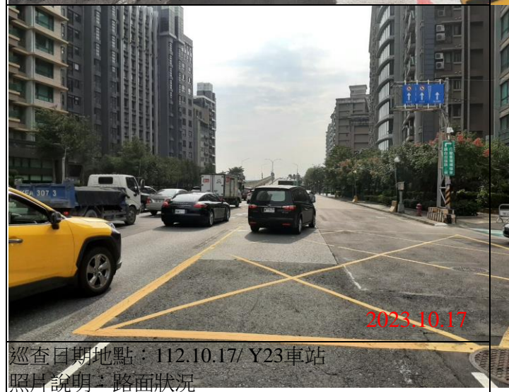
巡查日期地點：112.10.17/ Y23車站 照片說明：路面狀況
